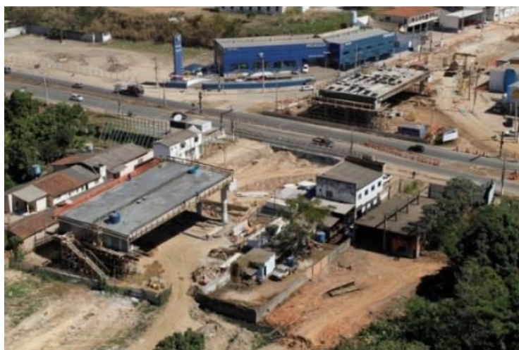
Foto 32: Visão oblíqua da obra do viaduto
