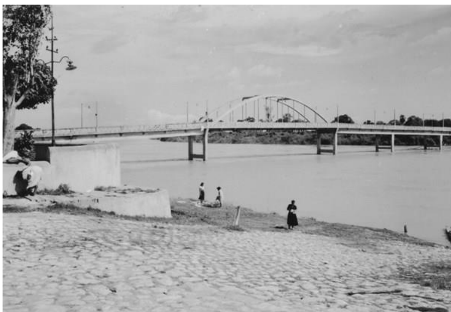
Foto 4: Ponte Júlio Müller em Cuiabá
