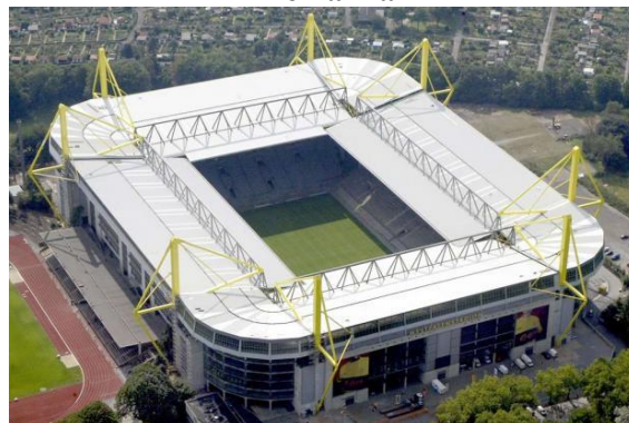
Foto 7: Exterior do estádio do Borussia Dortmund, time da cidade de Dortmund na Alemanha
