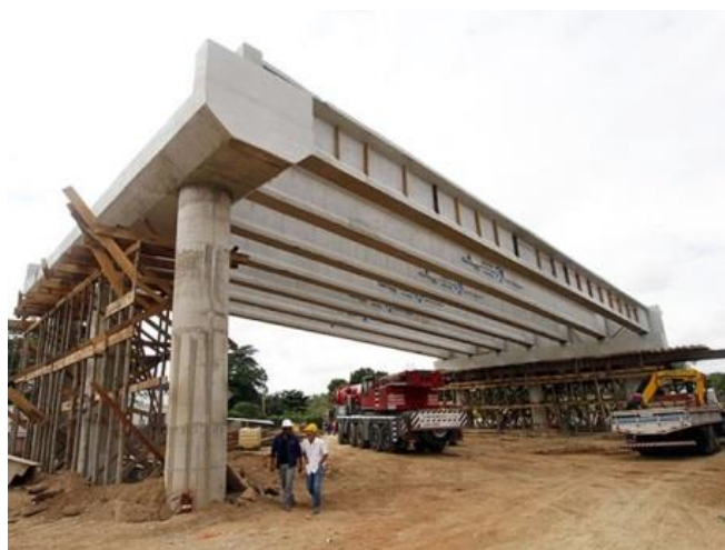
Foto 31: Levantamento das vigas
