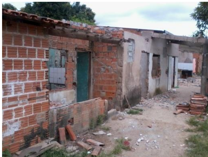
Foto 25: Aproveitamento das telhas de barro
