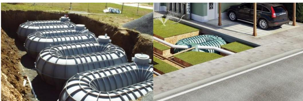
Figura 11 Reservatório enterrado de polietileno
