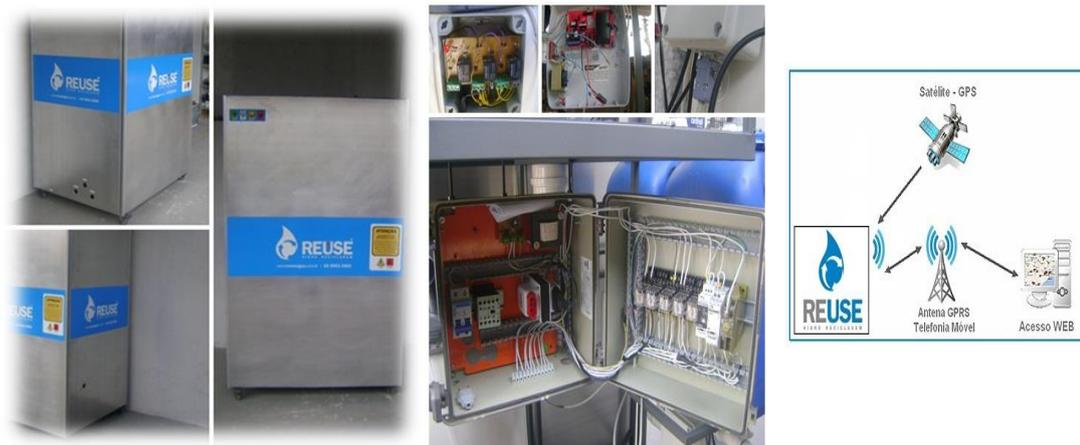
Figura 13 ETAR é um sistema de tratamento compacto, fechado em aço escovado, possui painel elétrico com sensores que emitem relatórios por meio de dados GPRS.
