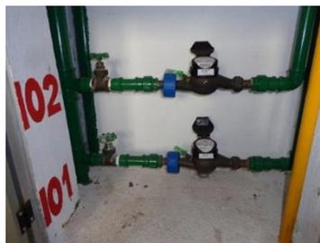
**Figura 18 Hidrômetros para medição individual.**
