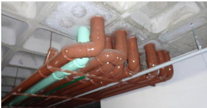
**Figura 36 Tubos de queda de esgoto em marrom localizados no estacionamento do subsolo.**
