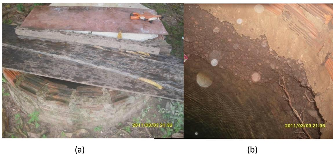
**Figura 17** - (a) Vista externa da cacimba C20, demonstrando forma inadequada de tamponamento; (b) vista interna mostrando um revestimento apenas sobre a superfície do terreno e exposição do perfil do solo com nível d'água próximo a superfície do terreno.
