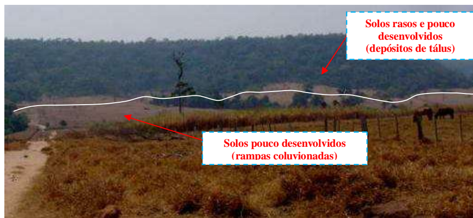
Figura 19 – Vista geral da escarpa com ocorrências de tálus e colúvios no sopé.
