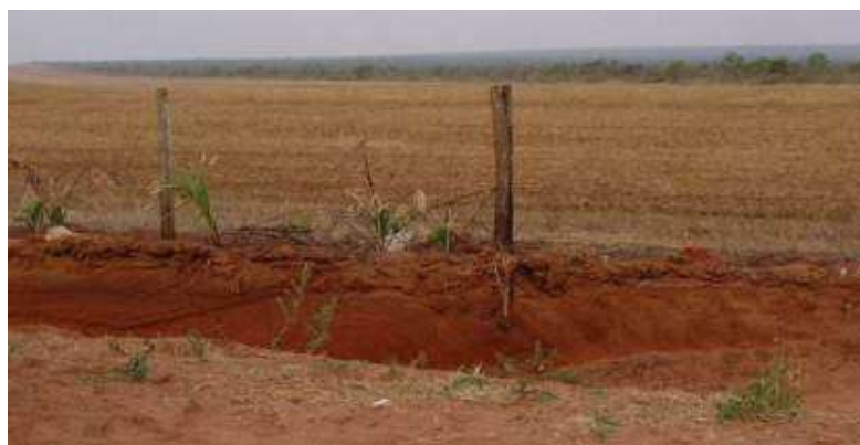
Figura 116 – Vista geral do compartimento MP-09, exibindo extensa área em rampas, constituído por Latossolo Vermelho Amarelo de textura média, exposto por trincheira em primeiro plano da imagem.
