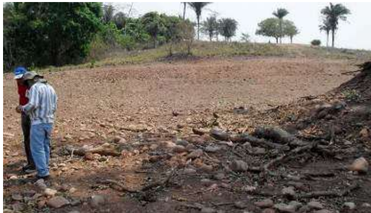
Figura 29 – Terreno de ocorrência de Cambissolo Háptico e Neossolo Litólico explorado como cascalheira para uso em pavimentação de estradas, originalmente constituída de vertentes com elevada inclinação.
