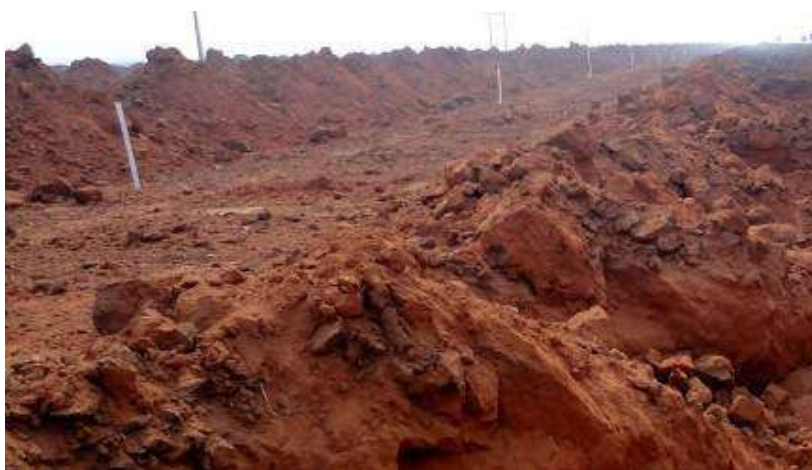
Figura 126 – Detalhe de material presente no compartimento MP-11, exibindo Latossolo Vermelho em área aplainada, onde se faz presente o traçado da BR-364, que recebe obras de pavimentação.
