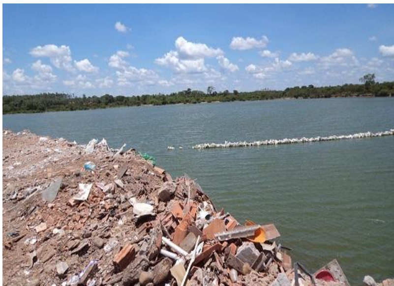
Figura 4 – Área de 12 hectares degradada pela retirada de argila sendo reaterrada em Várzea Grande-MT.
