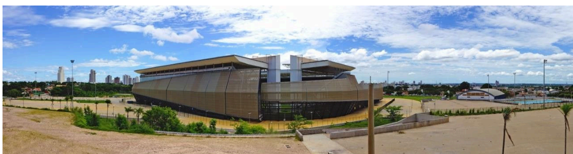
Figura 23 – Arena Pantanal, no final do processo de construção. Foto de R. Carracedo
