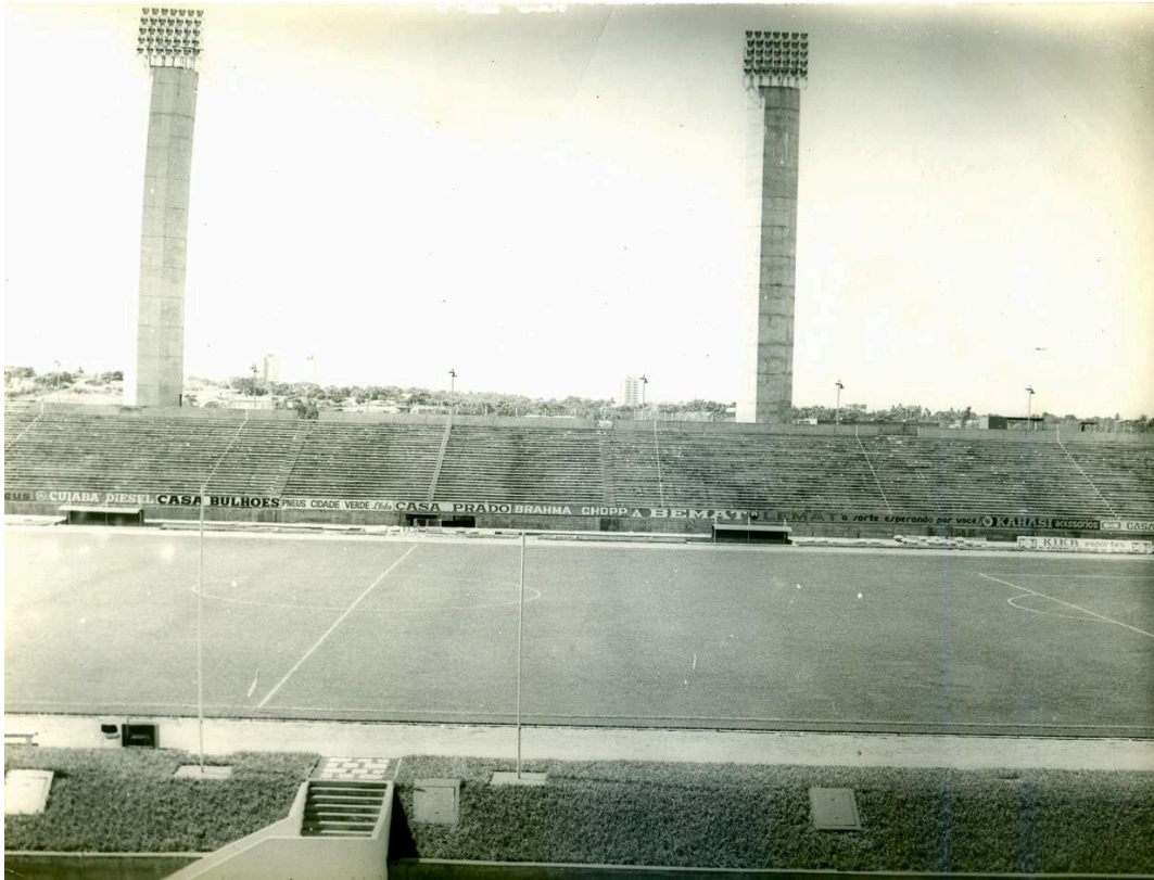
Figura 19 – Vista parcial do campo e arquibancadas do Verdão. Foto Chao.
