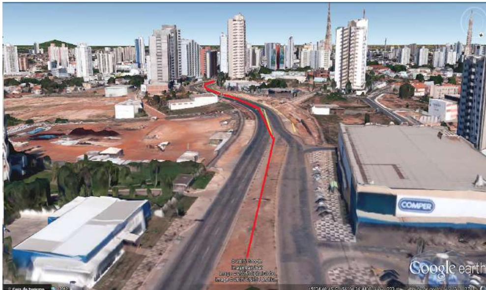
Figura 15 – Eixo 1 VLT em Cuiabá. Avenida Hist. Rubens de Mendonça destacado em vermelho. Estação do VLT - Senegal e Jardim Aclimação. Construção da Trincheira Luiz Felipe em Cuiabá paralisada.
