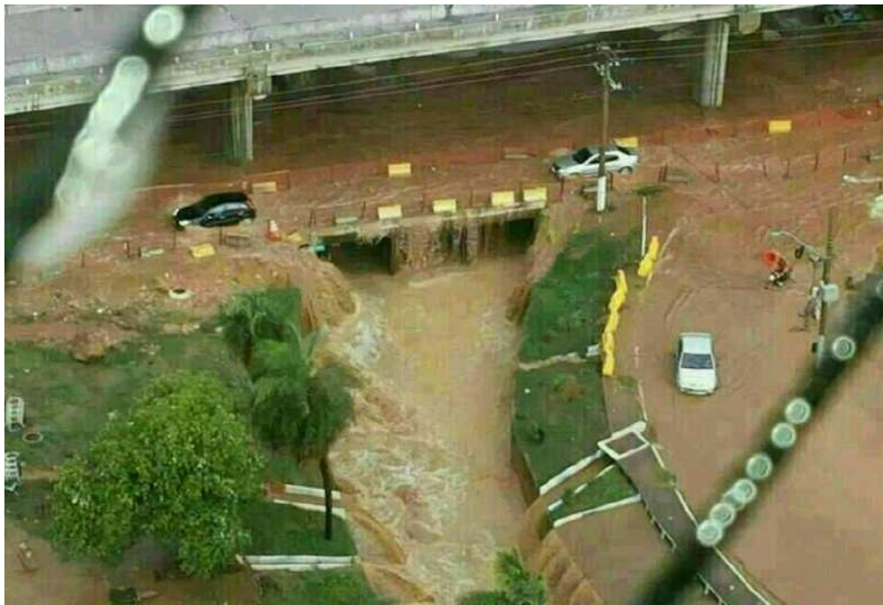
Figura 17 – Viaduto Da UFMT – Eixo 2. Sub-bacia do Córrego Barbado e drenagem urbana:
