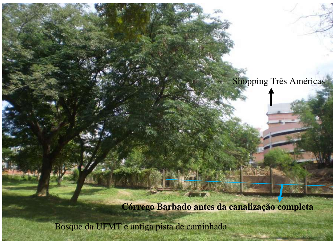
Figura 21 – Desmatamento da vegetação ripária do Córrego Barbado e o início da canalização.
