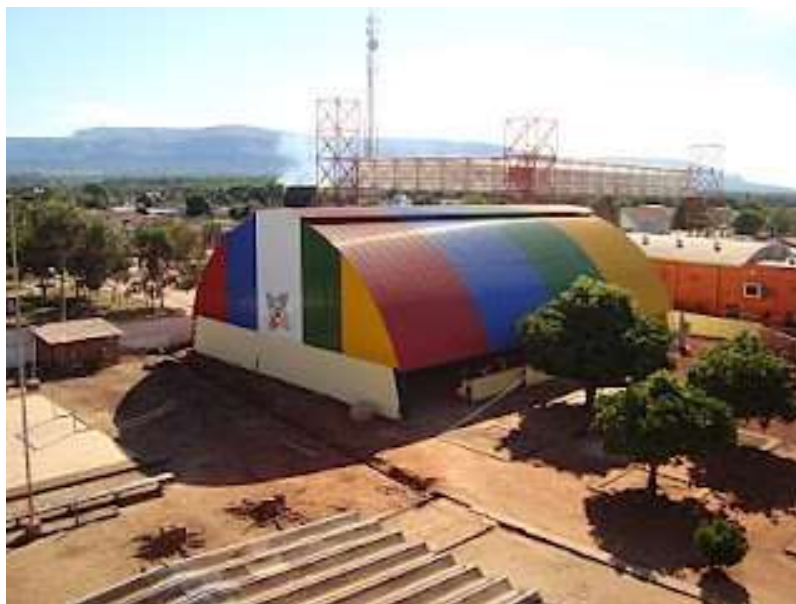
Figura 9. Vista aérea do espaço onde a escola está instalada.
