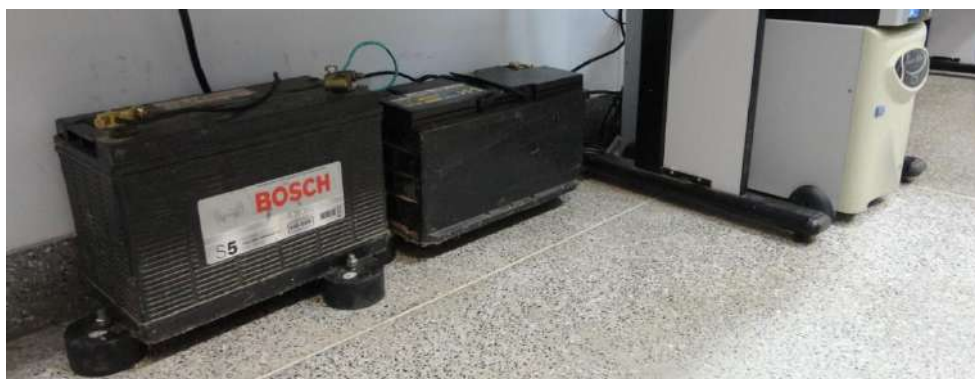
Figura 50 - NoBreak ligado às baterias automotivas
