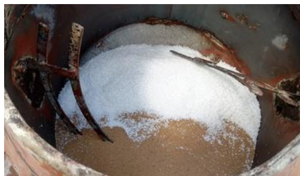
Figura 60 ĩ Preparação da argamassa em betoneira estacionária.
