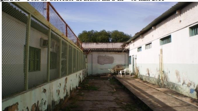
Figura 03 – Foto do Corredor de acesso ala d-E5 – 05 mai. 2011
