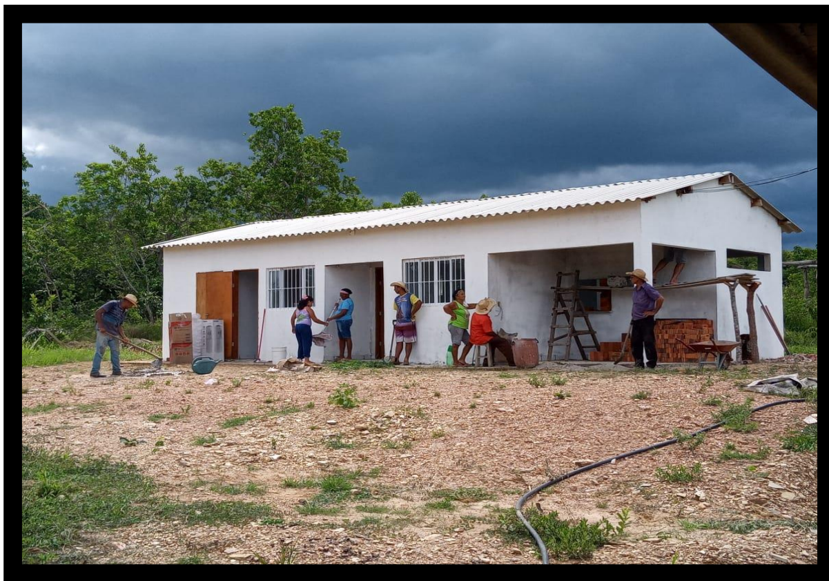
Imagem 42: Trabalho associado para a construção da nova cozinha
