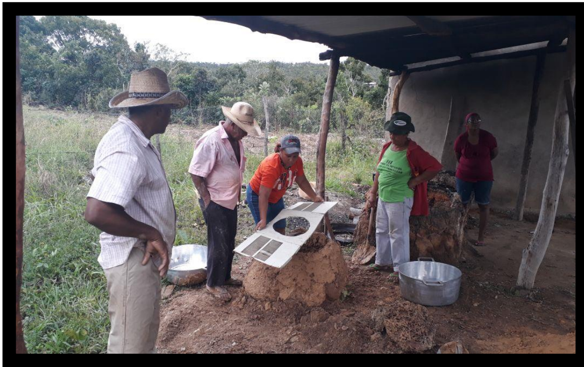
Imagem 23. Trabalho associado e autogestionado na reforma da antiga cozinha: produção de fornos.
