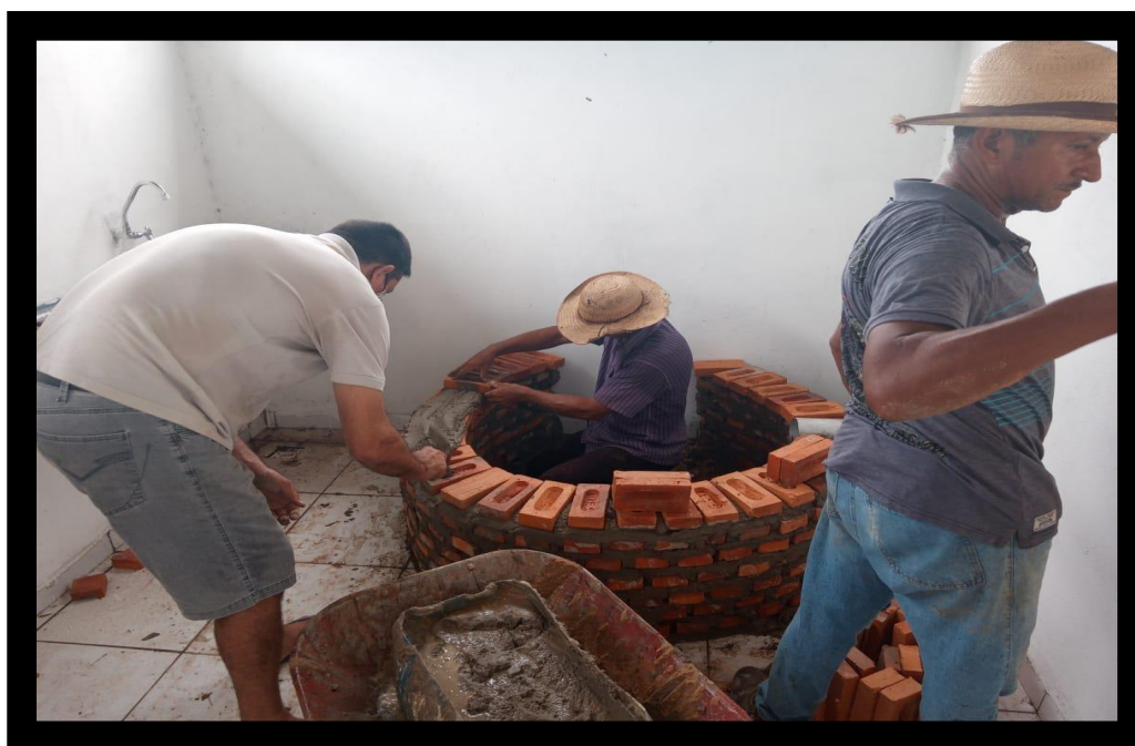
Imagens 43: Trabalho associado para a construção do forno na nova cozinha.
