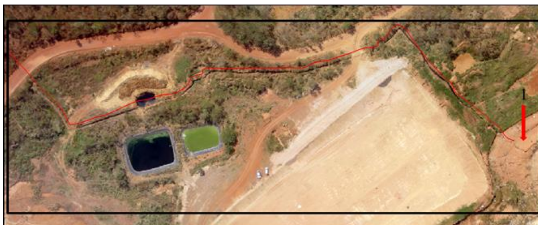
Figura 35 - Detalhe da figura 31 D. Canal erodido para percolação do chorume, saindo da base do maciço (1) em direção ao canal do Ribeirão do Lipa à jusante da barragem.
