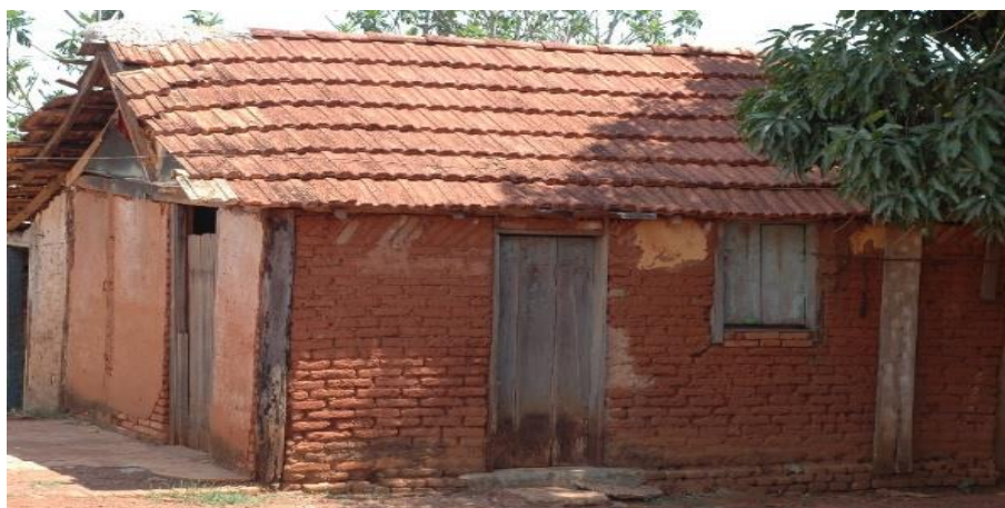
Figura 39: Casa construída com adobe (um tipo de tijolo feito com terra crua, água e palha).
