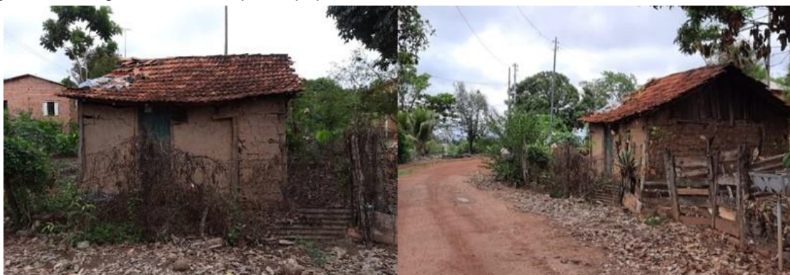
Figura 38: Antiga casa feita de pau-a-pique.
