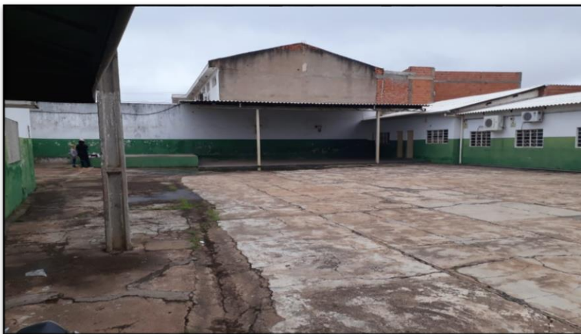
Foto 3: vista do pátio
