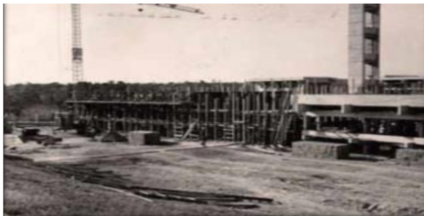
Figura 4 - Construção do Bloco de Tecnologias
