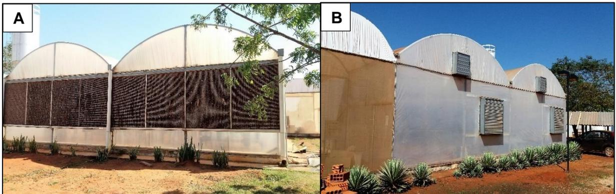
**Figura 1.** (A) Invernadero con panel de evaporación y (B) sistemas de extractores o ventiladores.
