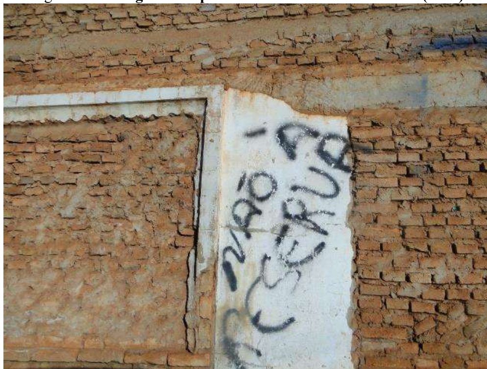
Figura 32 - Fotografia da parede de residência em Luciara (2017)
