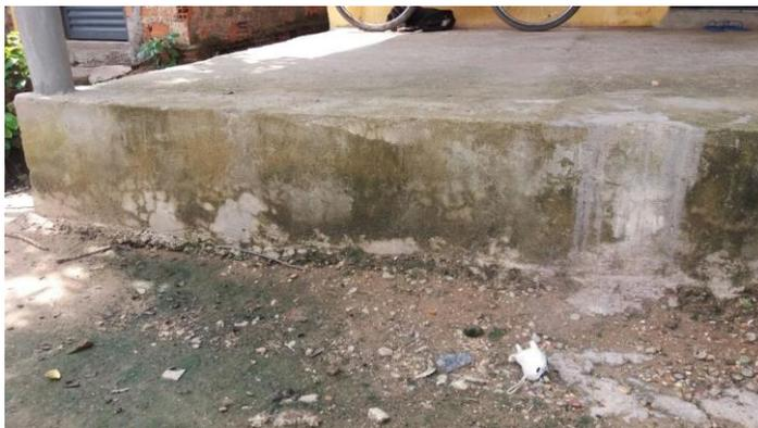
**Figura 15.** Degraus e alicerces de concreto utilizados para evitar a entrada da água nas residências no bairro do Lixá no município de Santo Antônio de Leverger (MT).
