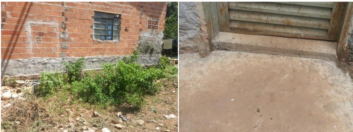
**Figura 23.** Aterro e degraus utilizados para impedir a entrada de água nas residências na comunidade Beira-rio no município de Santo Antônio de Leverger (MT).
