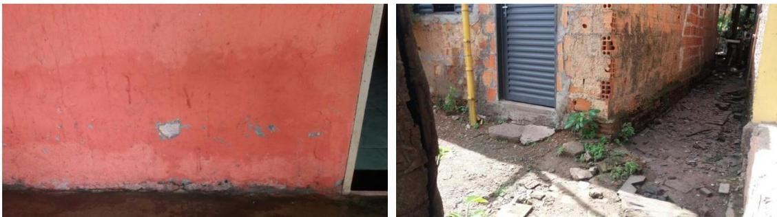
**Figura 17.** Manchas escuras e de umidade em paredes, muros e piso de casas do bairro do Lixá no município de Santo Antônio de Leverger (MT).
