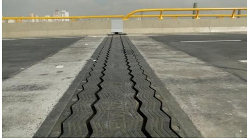
Figura 2.3: Juntas de dilatação numa ponte/viaduto. Fonte: (Brigadão, 2016).
