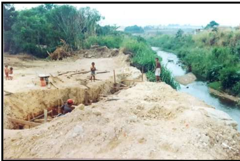
Figura 11 – Moradores construindo o sistema de esgoto
