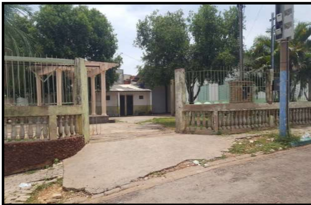
Figura 5 – Centro Comunitário João Henrique da Costa – imagem da entrada
