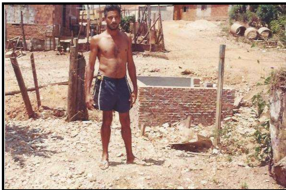
Figura 10 – Seu Nilo, construindo uma fossa
