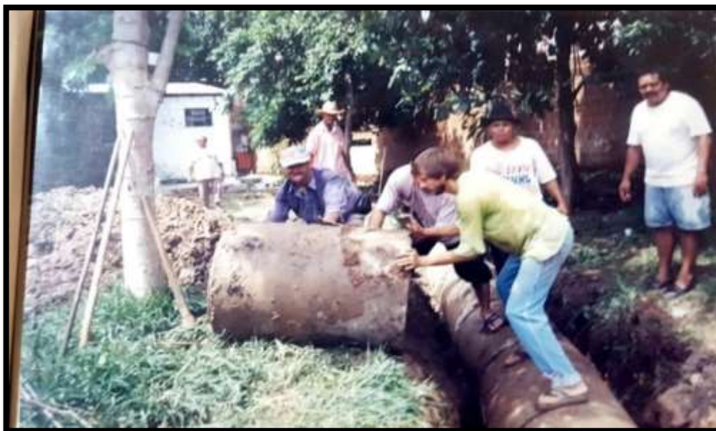
Figura 9 – Moradores canalizando esgoto
