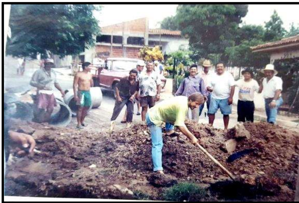
Figura 7 – Moradores canalizando o esgoto
