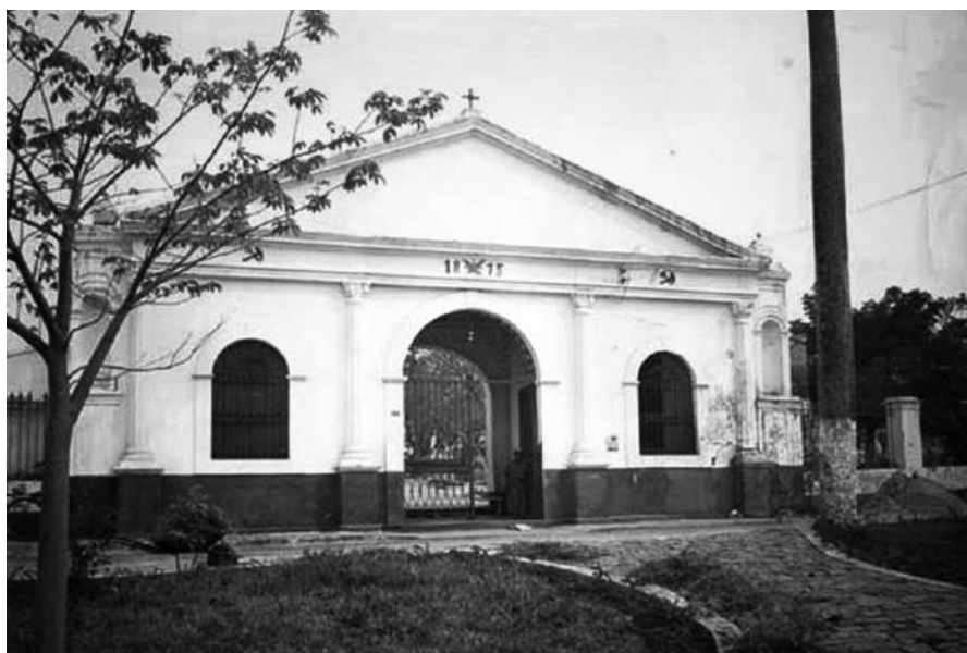
Figura 2: Antiga fachada do Cemitério Nossa Senhora da Piedade de Cuiabá-MT, inaugurado em 1875
