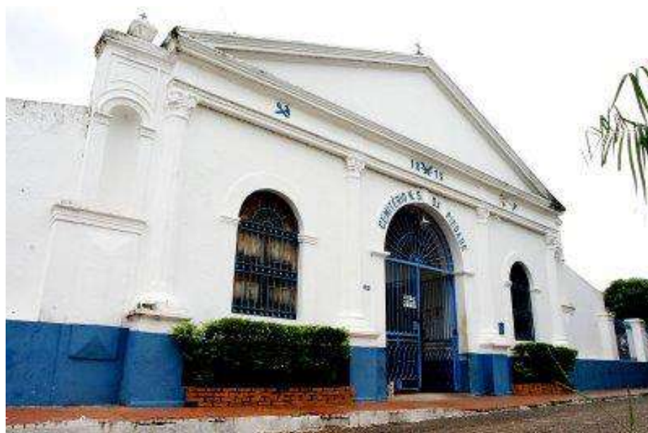
Figura 25: Foto da fachada do Cemitério Nossa Senhora da Piedade mostrando a cor da parede e das colunas antes branca, com a parte inferior azul
