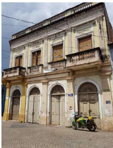
Figura 10: Fachada lateral da Casa Orlando, localizada no Centro Histórico de Cuiabá
