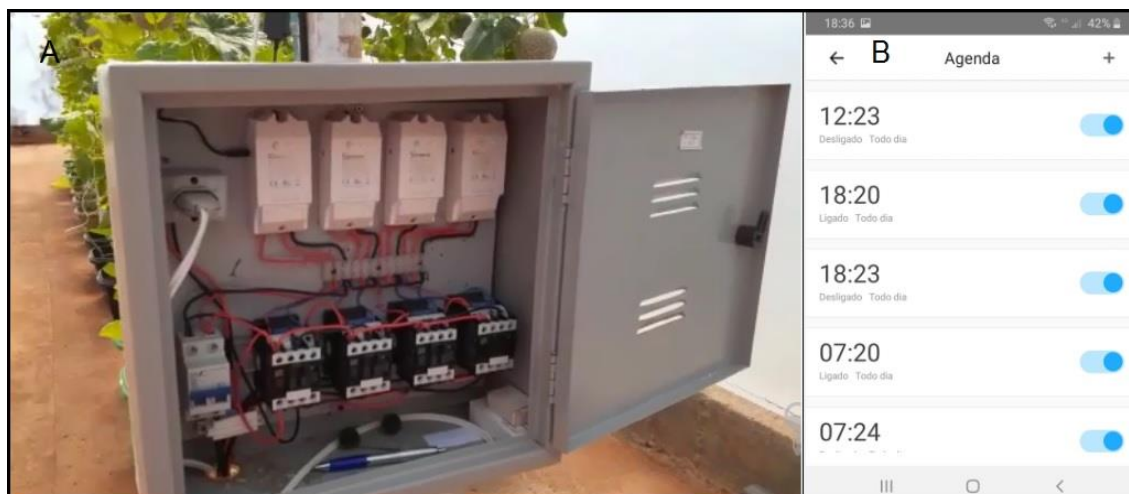
Figura 9. Painel de controle automatizado da irrigação instalado na estufa agrícola (A) e aplicativo de celular (B).
