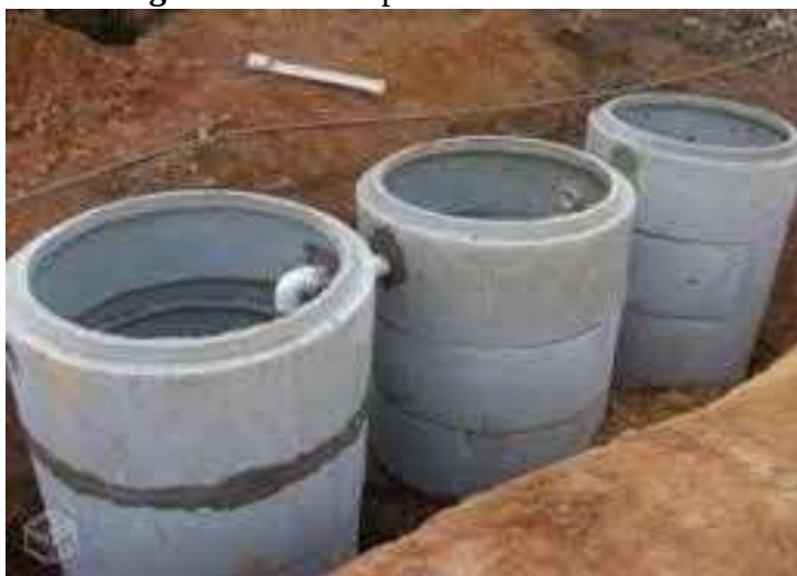
Figura 4: Fossa séptica de manilha
