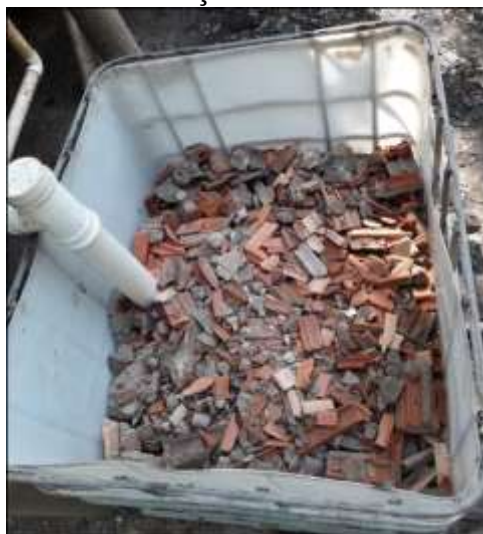
Figura 16: Acomodação de resíduos de construção
