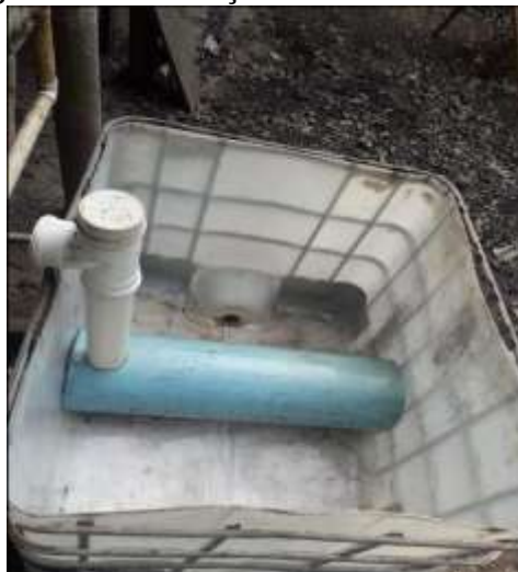
Figura 15: Instalação da câmara anaeróbia
