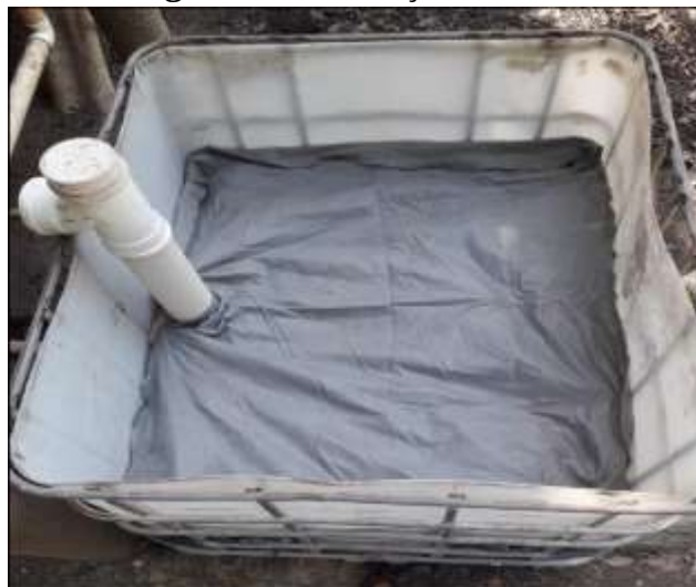
Figura 17: Instalação da manta bidim
