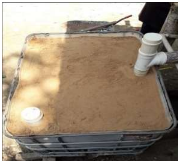
Figura 18: Preenchimento da camada de areia da localidade
