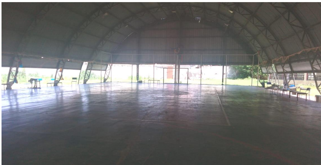
Figura 27 - Quadra coberta de Escola Estadual do Bairro Tijucal.
