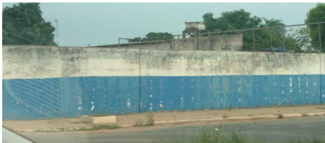
Figura 23 - Vista externa da quadra desativada.
