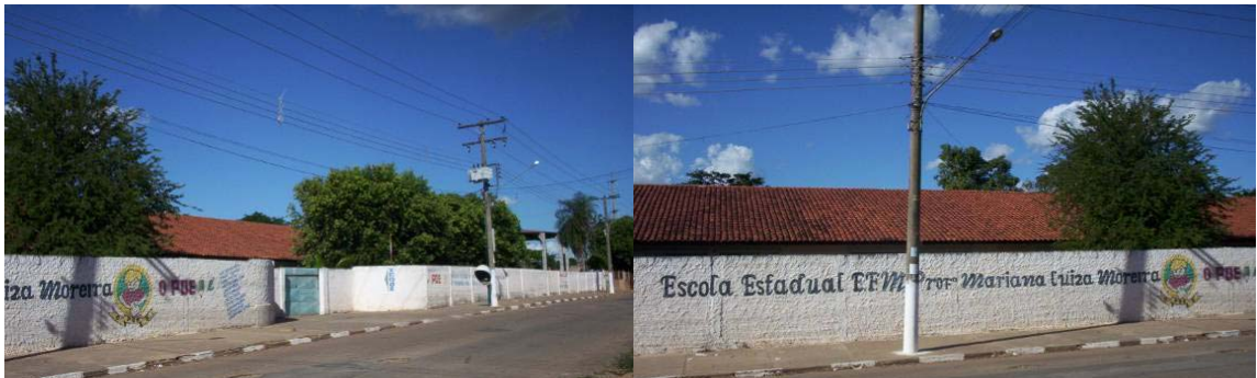
fotos 1 e 2: fachada da “Escola Mariana”.
