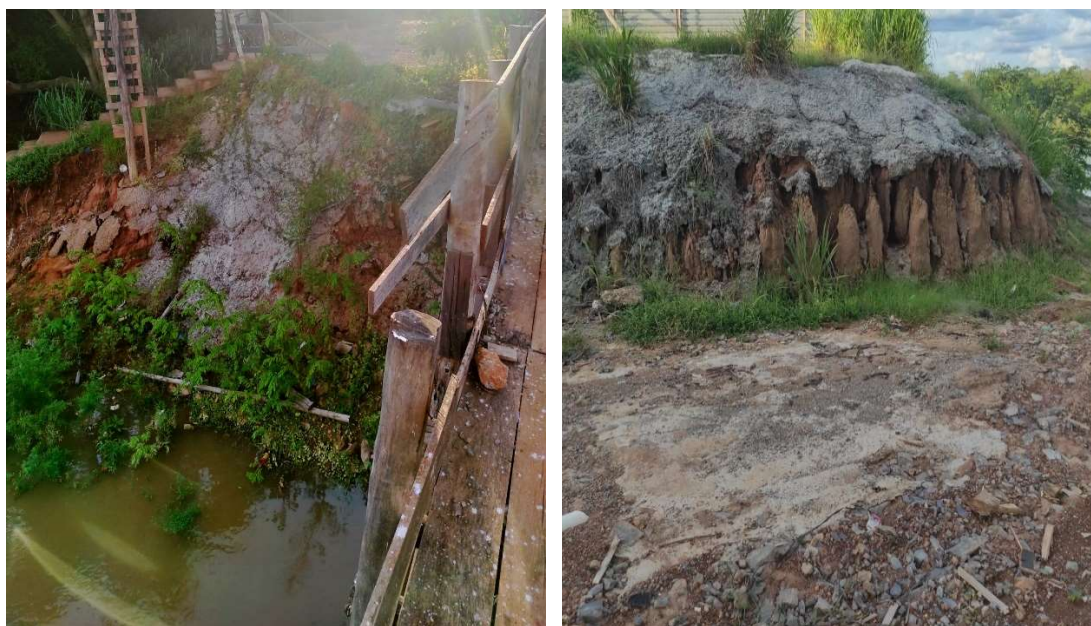
Figura 36 - RCC na ponte Parque Atalaia.
