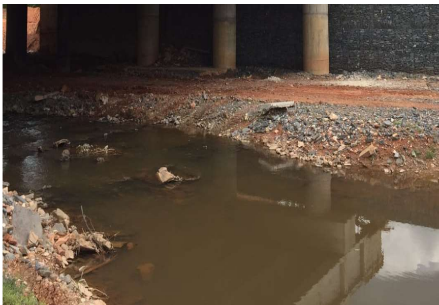
Figura 34 - RCC na ponte Ribeirão do Lipa.
