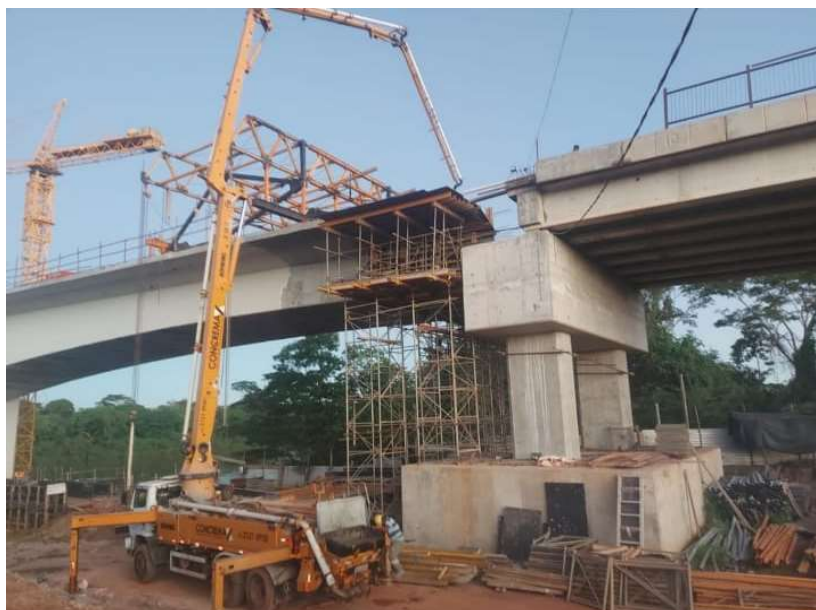
Figura 37 - Execução de concretagem na ponte Parque Atalaia.
