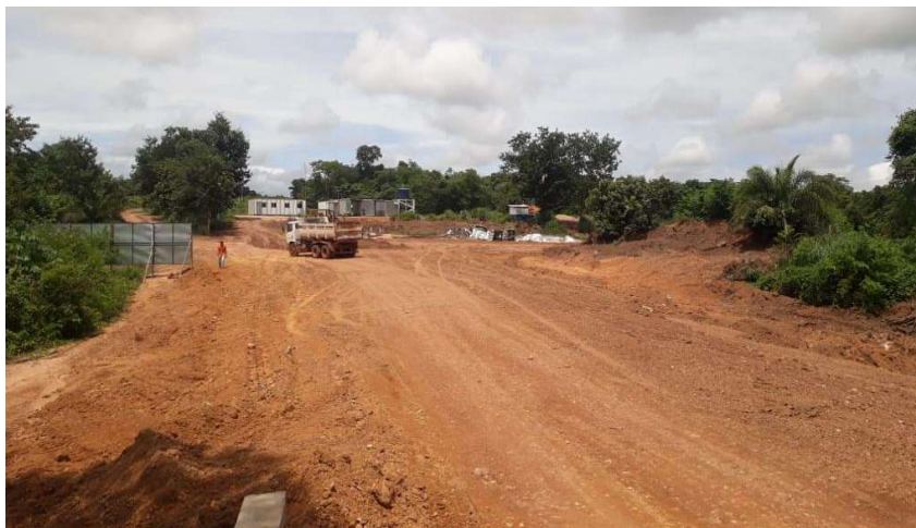
Figura 38 - Áreas desmatadas para canteiro de obras na ponte Rio Manso.
