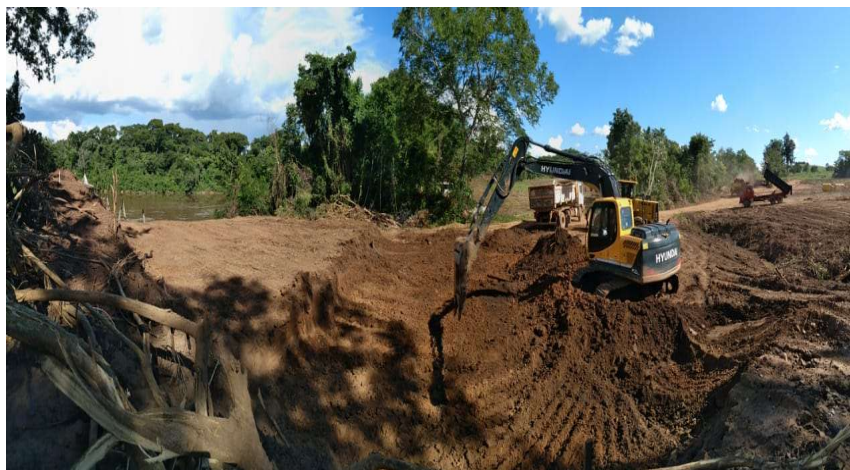
Figura 39 - Execução de limpeza de terreno na ponte Rio Manso.
