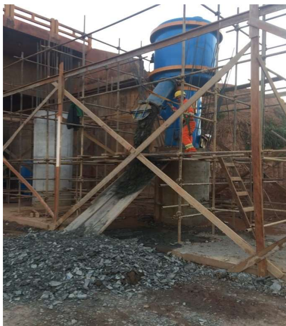
Figura 35 – Execução da escavação de materiais rochosos na ponte Ribeirão do Lipa.
