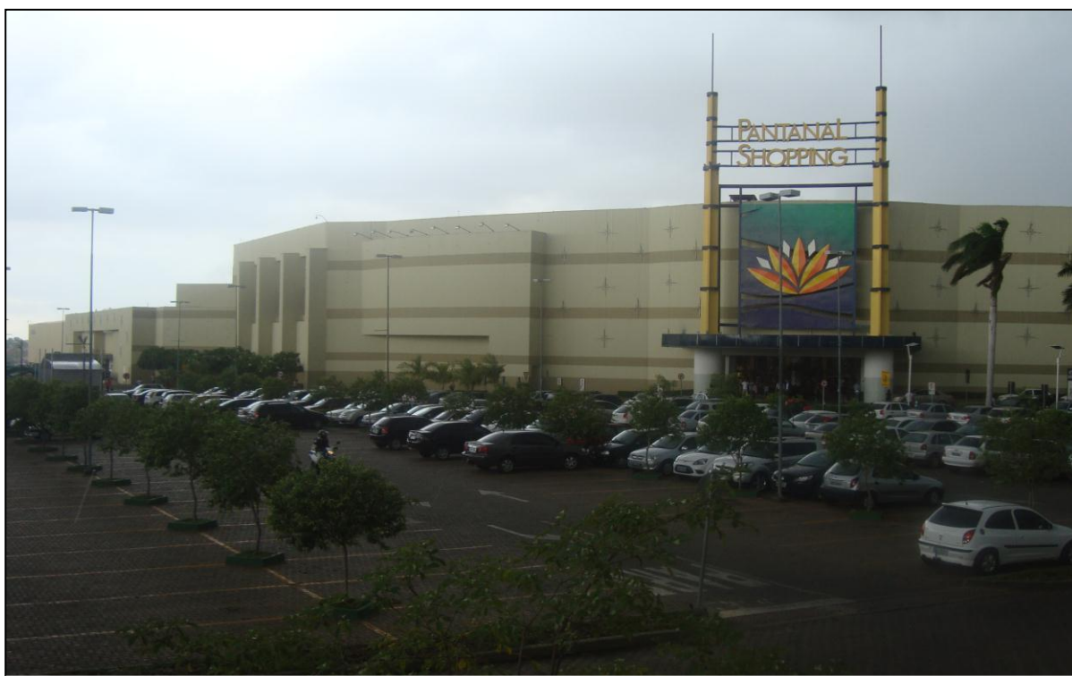
Figura 08: Vista parcial da entrada principal do Pantanal Shopping
